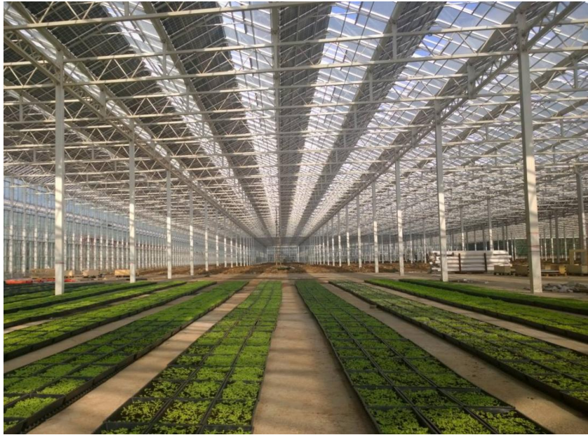
图 5-9：布置于文洛型温室西屋面的双玻光伏组件
